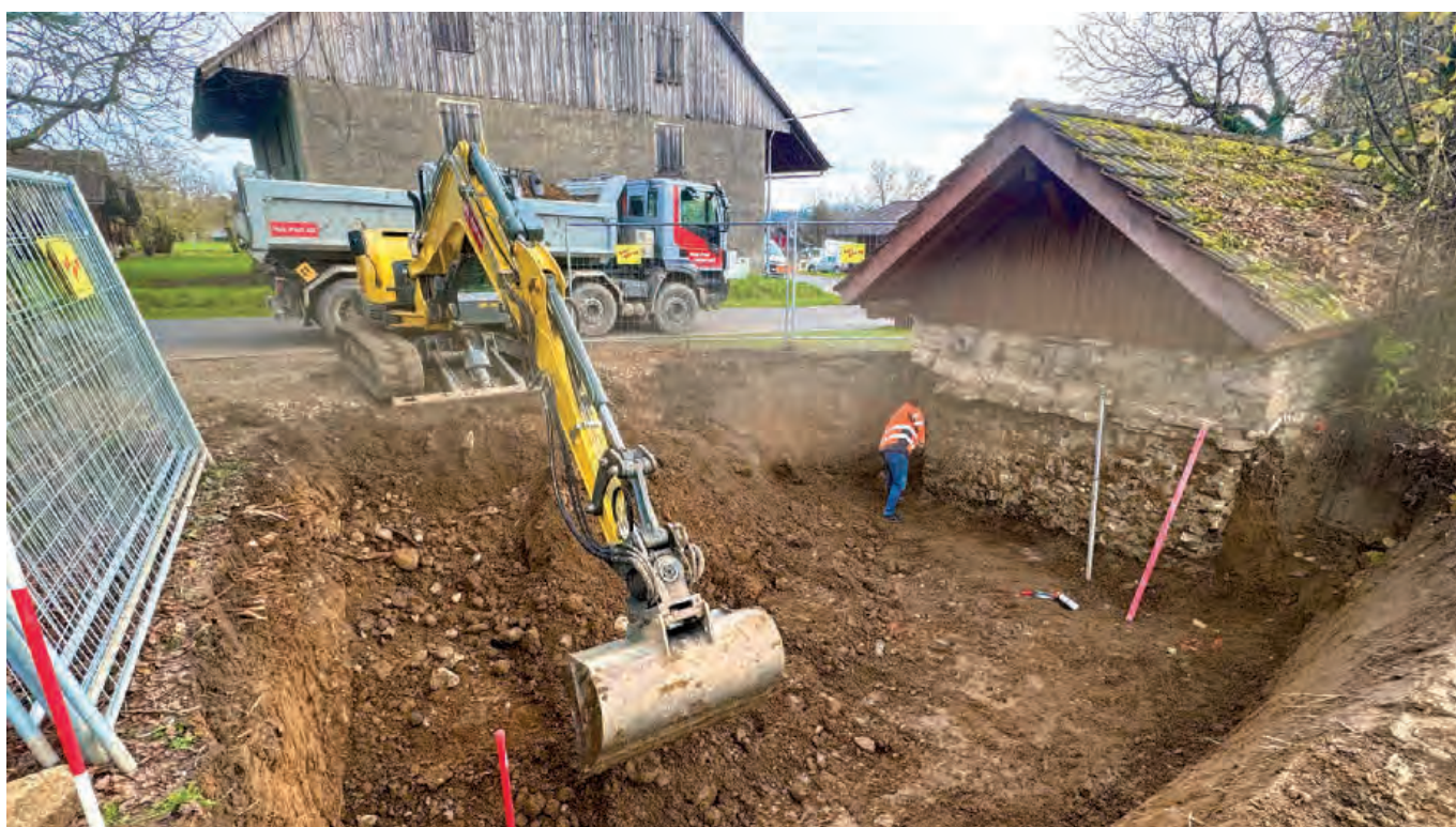
Aushub für den Ausbau – rechts im Bild ist die alte Rückwand des bisherigen Märthüsli zu sehen.
